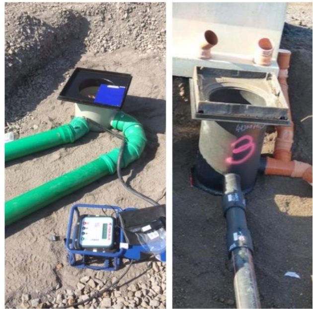
Die ersten und einzigen DIBT-zugelassenen Schächte für JGS-Anlagen können sowohl mit PE 100 Rohren als auch mit PP Rohren weiterführend kraftschlüssig verbunden werden.
